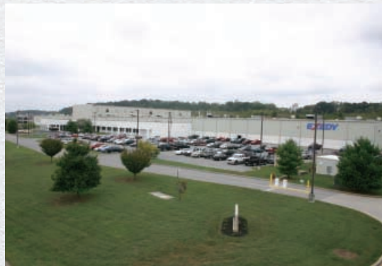
工場拡張工事が完了したエクセディア・アメリカ・コーポレーション
