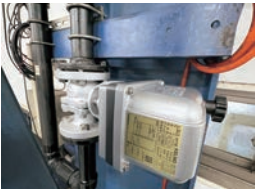
電動式 配管開閉バルブ
